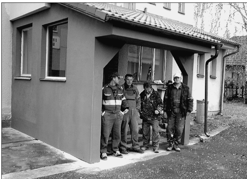
Parta pana Vl. Koláře provádí rekonstrukci verandy Obecního úřadu Kostomlaty nad Labem. foto: Antonín Bárta
